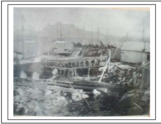
Tranøy Skipsverft på Slipodden
