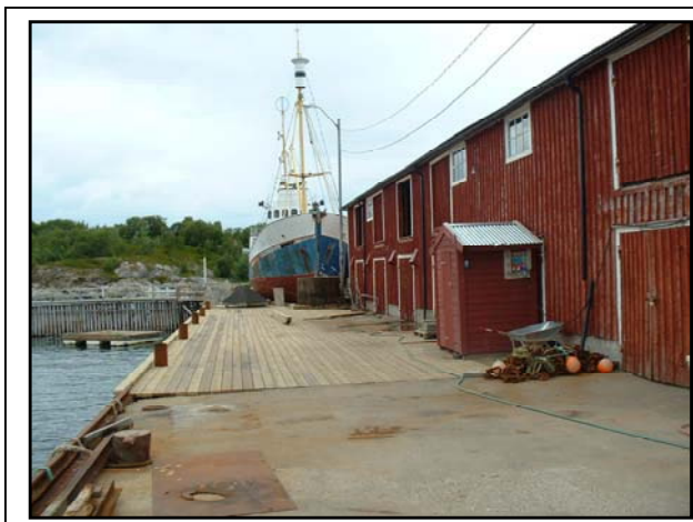
Kaidekket ble ferdig lagt i midten av juni 2002.
